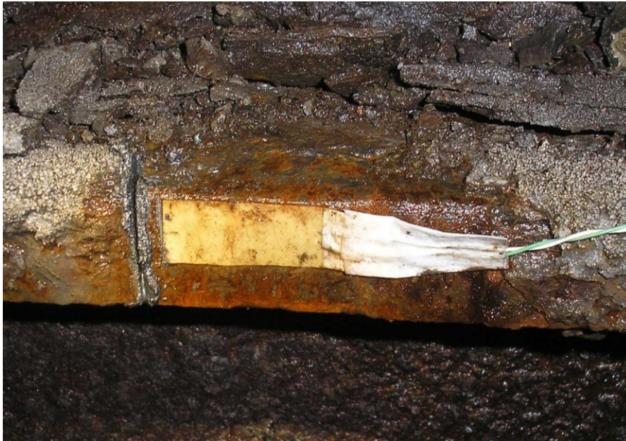
Рис. 4. Чугунная стенка ствола с тензодатчиком после применения метода частичной разгрузки
