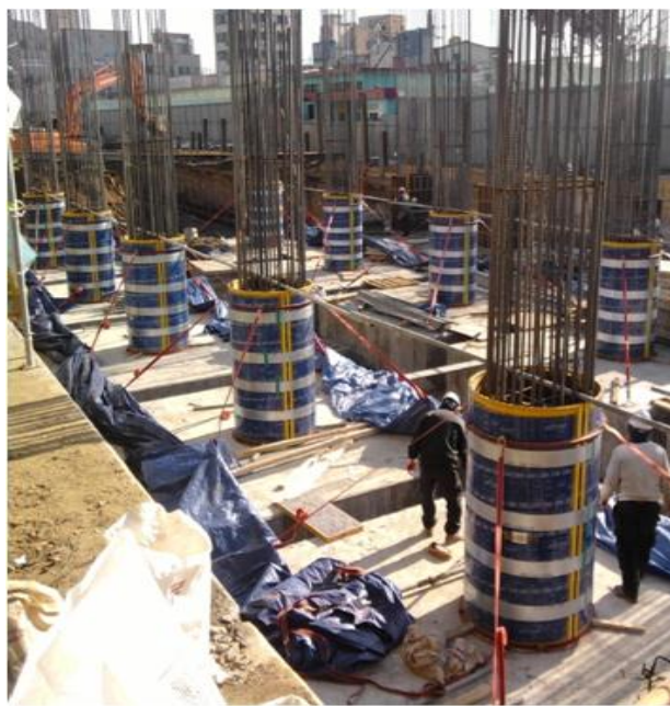
Рис. 2. Картонная опалубка для колонн и балок
