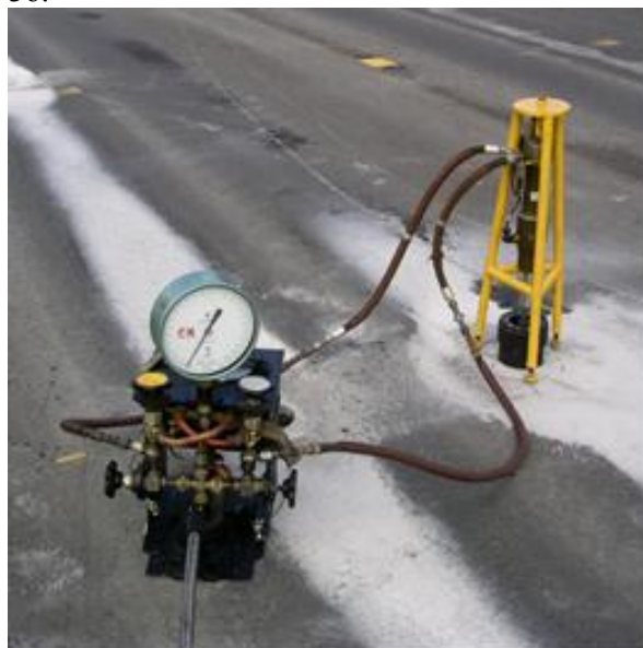
Рис. 2. Оценка сцепления слоев асфальтобетона в покрытии
